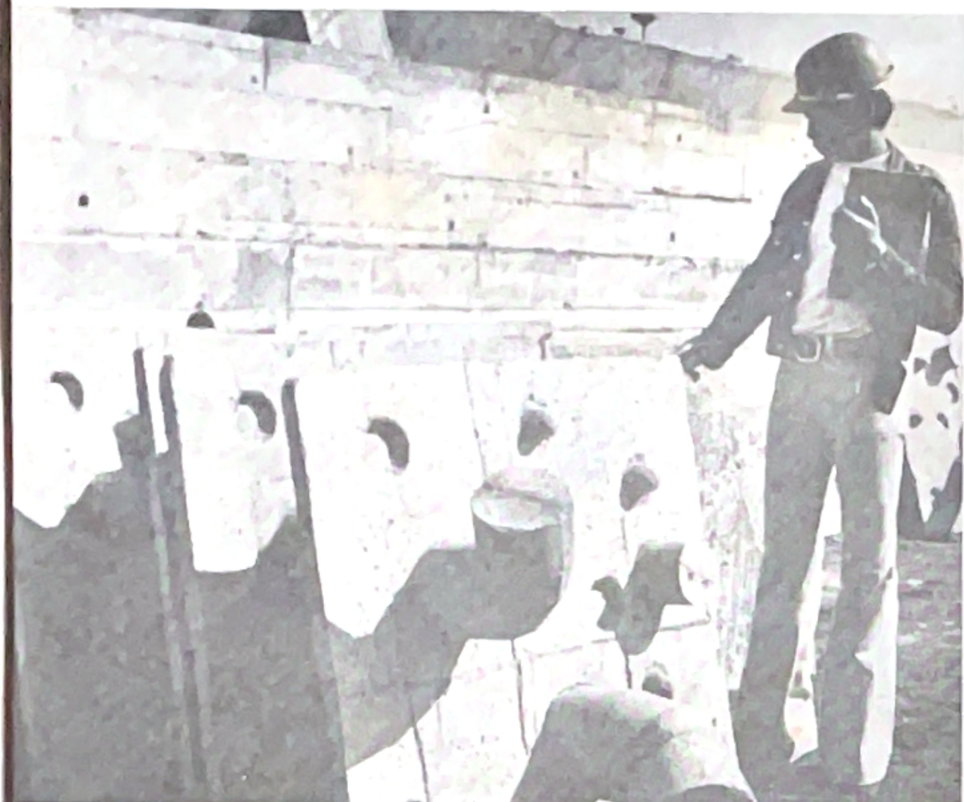
As placas, depois de moldadas só podem ser desenformadas no dia seguinte.
