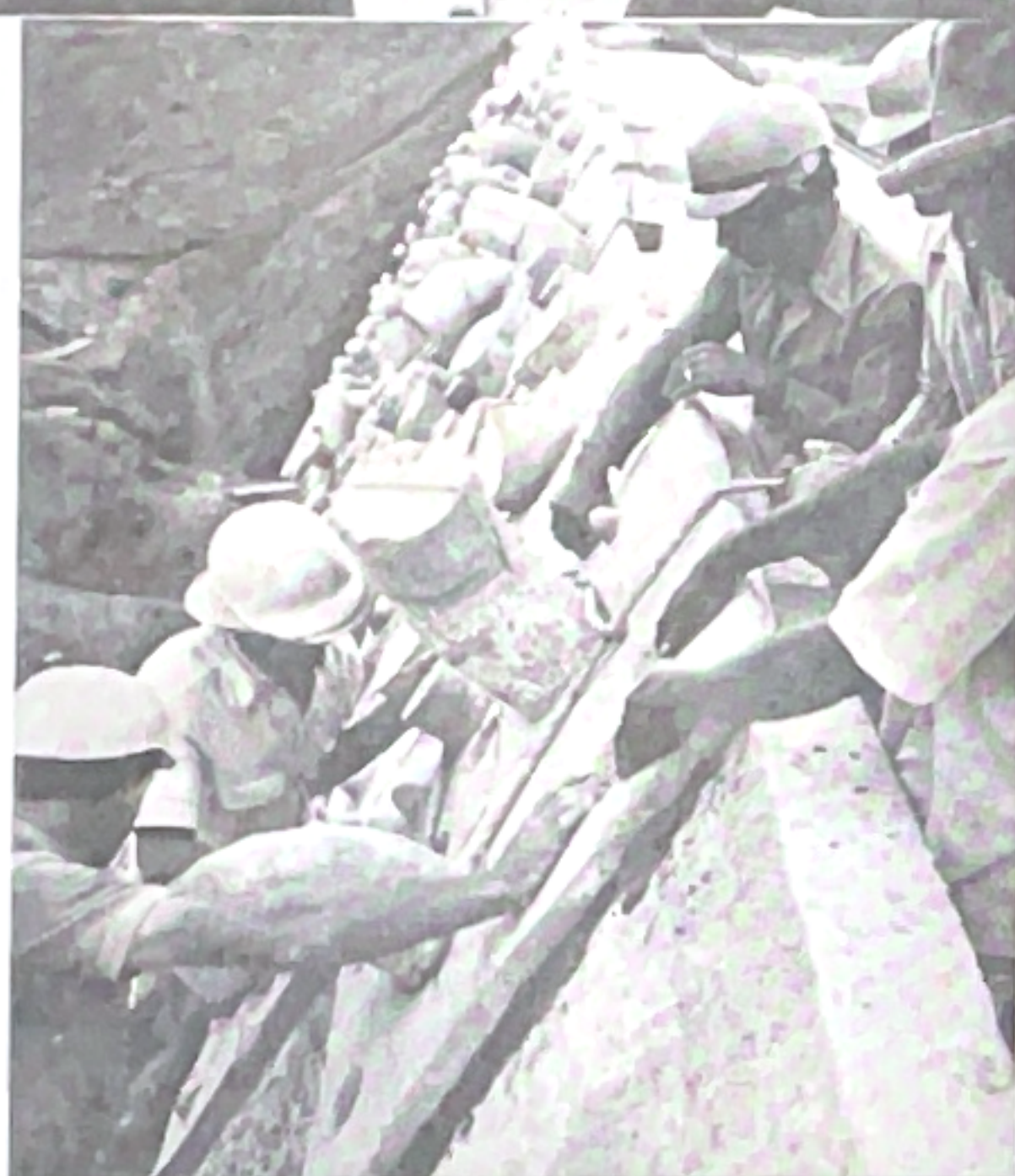
Presas ao muro, as placas ainda levam 4 tiros de pistola comum ficando solidamente colocadas.
